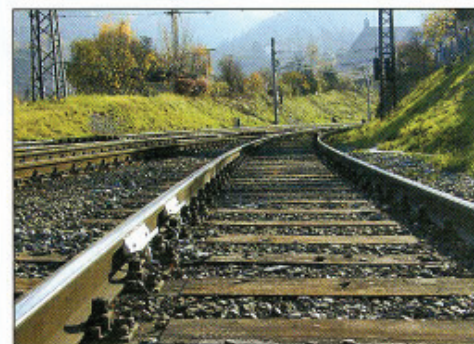
Abb. 8: Beispiel für die Flankenschmierung.
