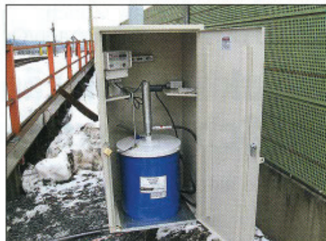
Abb. 3: Darstellung eines stationären Schmiersystems.
